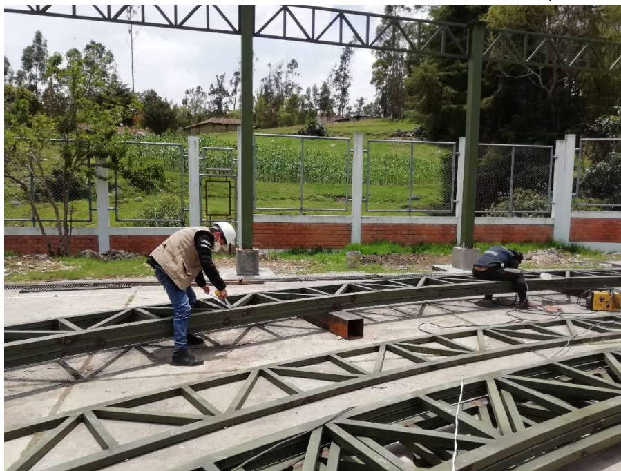
IMAGEN 02: HABILITACIÓN DE ARMADURA METALICA TIPO ARCO (LUZ = 22 M)
