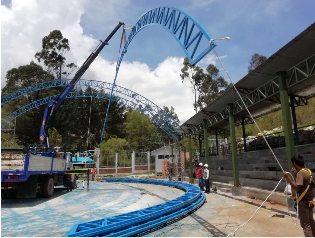
IMAGEN 05: IZAMIENTO DE ARMADURAS METÁLICAS
