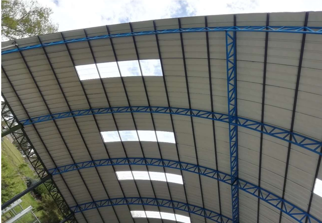
IMAGEN 06: COBERTURA ALUZINC CURVO OPACO DE 0.40 MM
