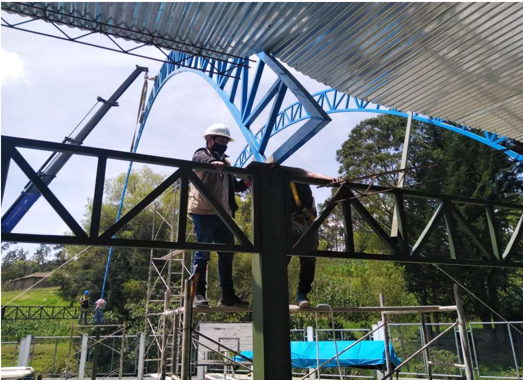
IMAGEN 10: VERIFICACIÓN DE TRABAJOS EN ALTURA
