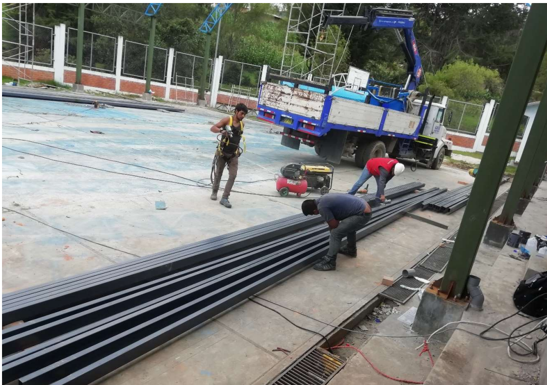
IMAGEN 04: COLOCACIÓN DE SEGUNDA CAPA DE PINTURA ESMALTE EN CORREAS DE TUBO RECTANGULAR 2"X4"X 2.50 MM
