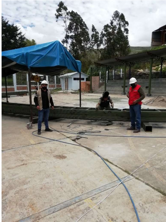
IMAGEN 01: TRABAJOS EN ARMADURA METÁLICA TIPO ARCO.
