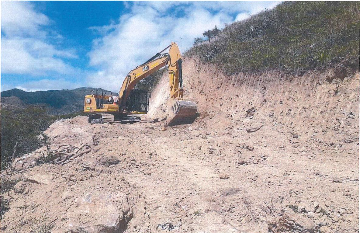
Foto N°04. Se realizó la verificación del corte de roca suelta.
