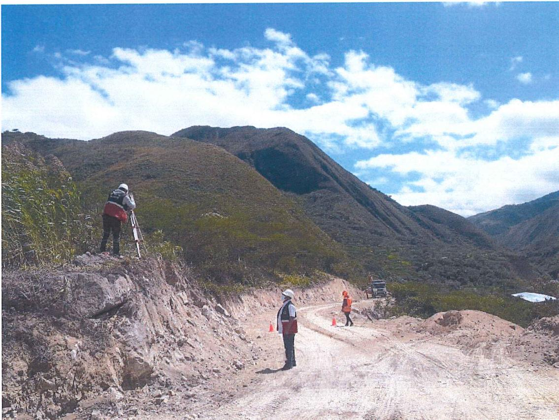
FOTO N° 08: Se realiza el control de los trabajos es el caso alineamiento, altura de cortes, taludes, etc.
