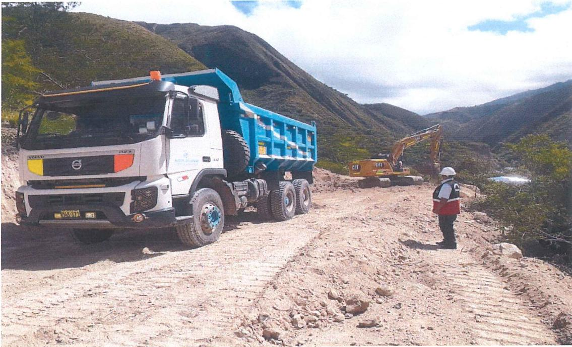
FOTO N° 07: Se Verifica la ejecución de la partida Movimiento de Tierras (excavación, remoción y transporte de los materiales, en la progresiva de 00+00 al 1+920 km)
