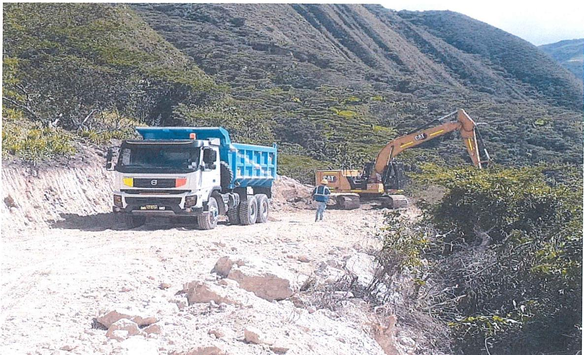
Foto N°06. Se verifica el transporte de material excedente a botaderos autorizados por la supervisión
