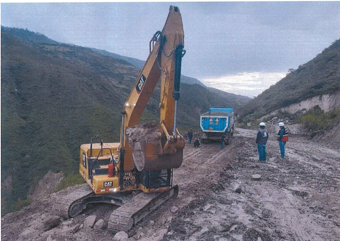
FOTO N° 06: Se verifica la ejecución de la partida Movimiento de Tierras (excavación, remoción y transporte de los materiales, en la progresiva 11+646 a 10+500 km).
