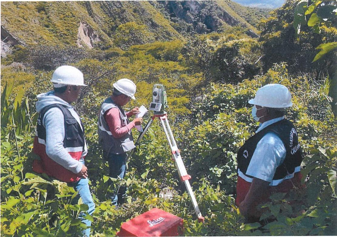
FOTO N° 01: Verificación de trabajos de replanteo topográfico ejecutado por la contratista.
