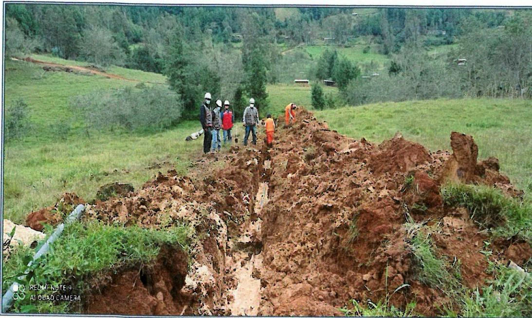
FOTOGRAFIA N°11: En la siguiente vista se observa a la Supervisión, Residente y Personal Técnico inspeccionando las actividades de la partida 08.02.02.05 RELLENO Y COMPACTACION DE ZANJAS MANUAL de la partida 08.02.02 MOVIMIENTO DE TIERRAS de la partida 08 LINEA DE DISTRIBUCION de la partida 08 SISTEMA DE RIEGO - NUEVO TRIUNFO.
