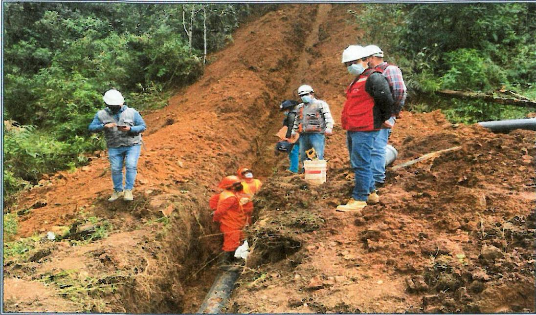
FOTOGRAFIA N°17: En la siguiente vista se observa a equipo técnico de la supervisión y de residencia de obra realizando trabajos en la partida 06.03.03.04 SUMINISTRO E INST. DE TUBERIA PVC 63 mm C – 5 MM de la partida 06.03.03 TUBERIAS De la partida 6.03 LINEA DE DISTRIBUCION de la partida 06 SISTEMA DE RIEGO 1 – MARCOPATA.
