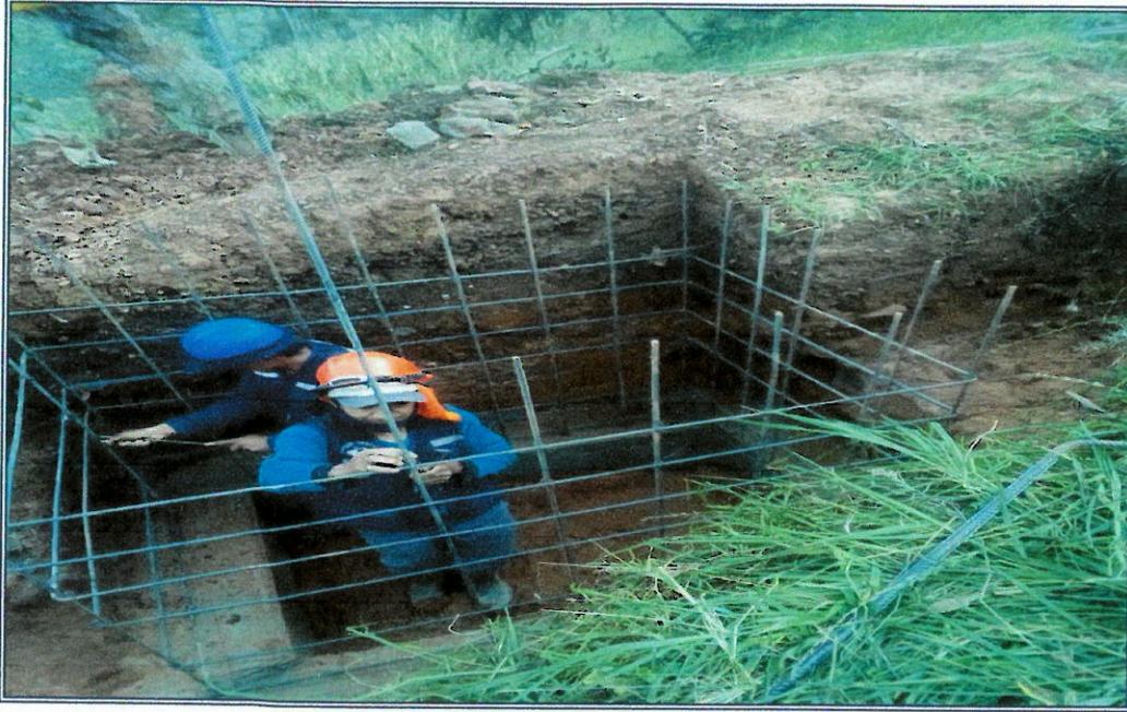
FOTOGRAFIA N°07: En la siguiente vista se observa a la Supervisión, Residente y Personal Técnico de la Gerencia Subregional de Chota inspeccionando las actividades 05.02.04 ACERO DE REFUERZO Fy=4200 KG/CM2 de la partida 05.02.04 OBRAS DE CONCRETO ARMADO, de la partida. 05.02 VALVULAS DE CONTROL 05 SISTEMA DE RIEGO SANTA CLARA.
