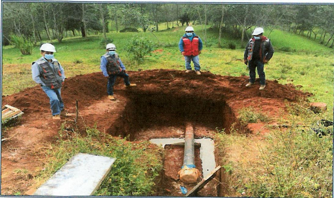
FOTOGRAFIA N°04: En la siguiente vista se observa a la Supervisión, Residente y Personal Técnico de la Gerencia Subregional de Chota inspeccionando las actividades 05.02.03.01 SOLADO DE CONCRETO F'C=100KG/CM2 de la partida 05.02.03 OBRAS DE CONCRETO SIMPLE, de la partida. 05.02 VALVULAS DE CONTROL 05 SISTEMA DE RIEGO SANTA CLARA
