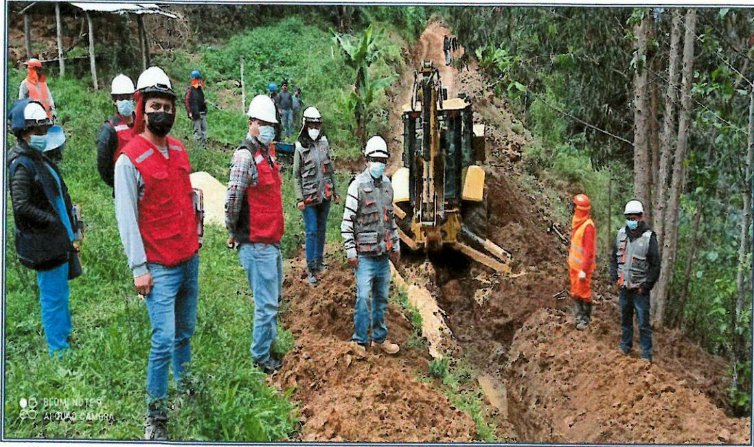
FOTOGRAFIA N°23: En la siguiente vista se observa a la Supervisión, Residente y Personal Técnico apreciando la ejecución de la partida 08.02.02.02 EXCAVACION MASIVA CON MAQUINARIA EN ZANJA, de la partida 08.02.02 MOVIMIENTO DE TIERRAS, de la partida 8.02 LINEA DE DISTRIBUCION de la partida 8 SISTEMA DE RIEGO - NUEVO TRIUNFO.
