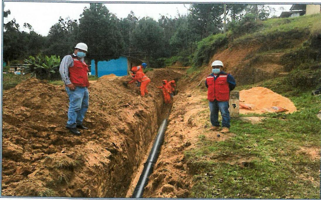
FOTOGRAFIA N°15: En la siguiente vista se observa a la Supervisión, Residente y Personal Técnico inspeccionando las actividades de la partida 08.02.02.05 RELLENO Y COMPACTACION DE ZANJAS MANUAL de la partida 08.02.02 MOVIMIENTO DE TIERRAS de la partida 08.02 LINEA DE DISTRIBUCION de la partida 08 SISTEMA DE RIEGO - NUEVO TRIUNFO.
