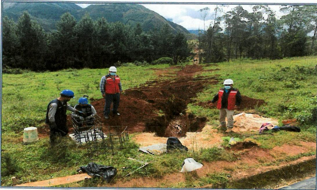
FOTOGRAFIA 10: En la siguiente vista se observa a la Supervisión, Residente y Personal Técnico inspeccionando las actividades 06.04.04.03 ACERO DE REFUERZO Fy=4200 KG/CM2 de la partida 05.02.04 OBRAS DE CONCRETO ARMADO, de la partida. 05.02 VALVULAS DE CONTROL 06 SISTEMA DE RIEGO 1 MARCOPATA.
