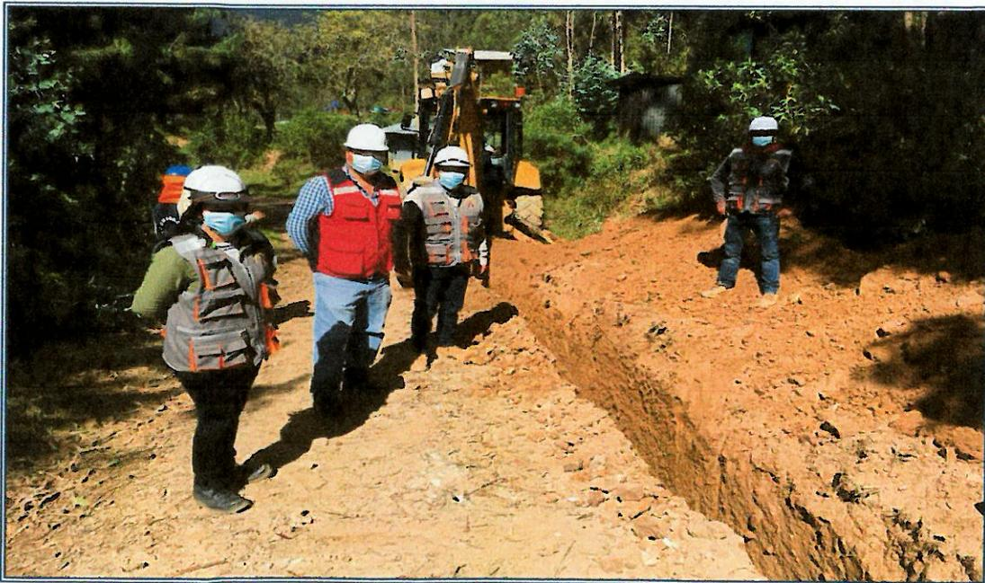
FOTOGRAFIA N°22: En la siguiente vista se observa a residente y supervisor de obra observando los trabajos realizados de la partida 08.02.02.02 EXCAVACION MASIVA CON MAQUINARIA EN ZANJA, de la Partida 08.02.02 MOVIMIENTO DE TIERRAS, de la partida 8.02 LINEA DE DISTRIBUCION de la partida 08 SISTEMA DE RIEGO - NUEVO TRIUNFO.
