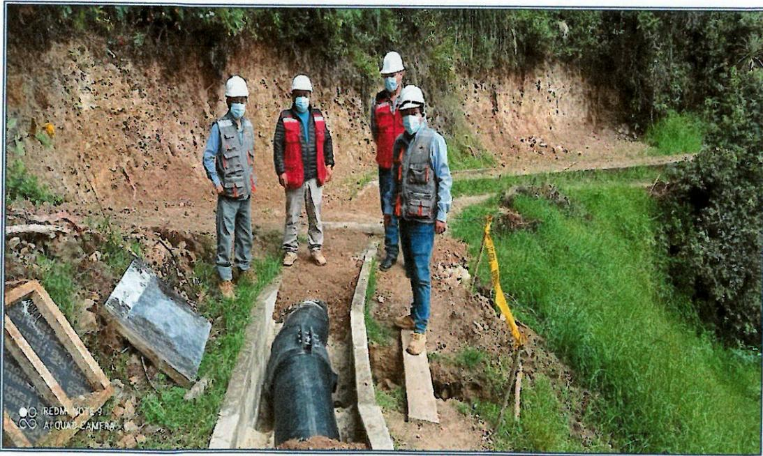
FOTOGRAFIA N°08: En la siguiente vista se observa a la Supervisión, Residente y personal técnico inspeccionando las actividades de la partida 03.01.04 RELLENO NO COMPACTADO CON MATERIAL PROPIO, de la Partida 3.01 MOVIMIENTO DE TIERRAS, de la partida 3 TUBERIA DE CONDUCCION.
