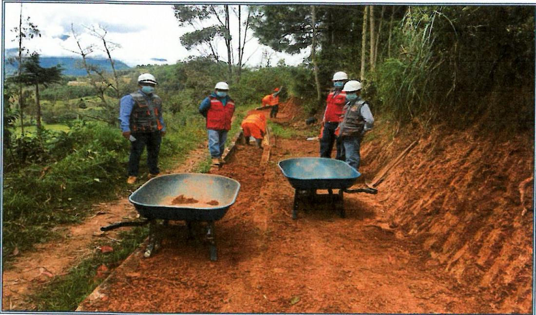
**FOTOGRAFIA N°01:** En la siguiente vista se observa a la Supervisión, Residente y personal técnico inspeccionando las actividades de la partida 03.01.04 RELLENO NO COMPACTADO CON MATERIAL PROPIO, de la Partida 3.01 MOVIMIENTO DE TIERRAS, de la partida 3 TUBERIA DE CONDUCCION.
