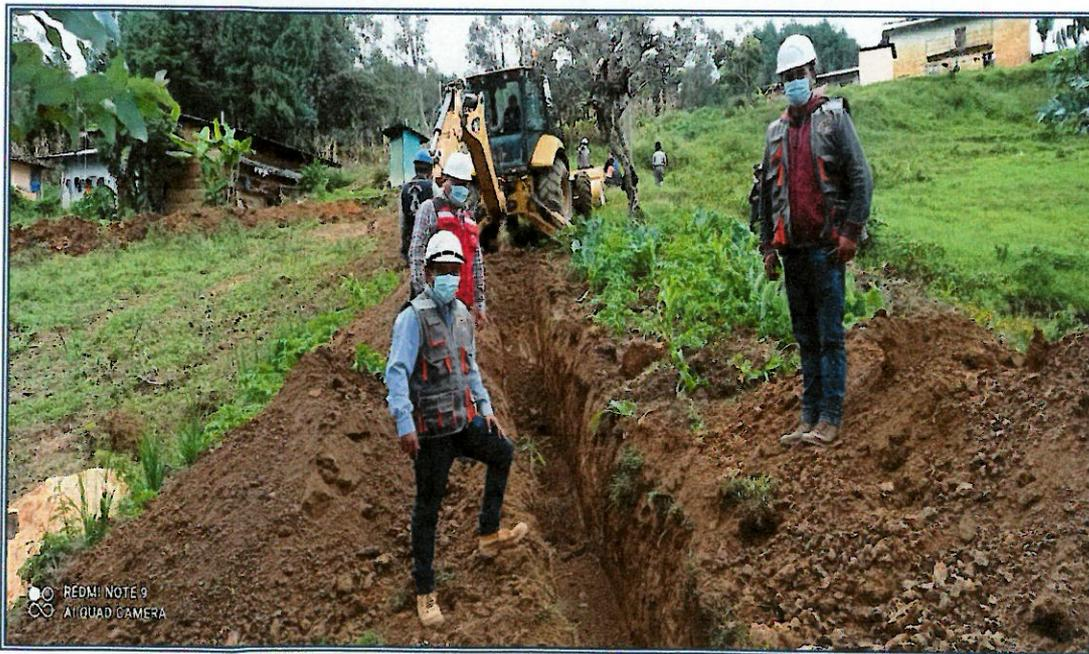
FOTOGRAFIA N°06: En la siguiente vista se observa a la Supervisión, Residente y Personal Técnico inspeccionando las actividades de la partida 06.03.02.02 EXCAVACION MASIVA CON MAQUINARIA EN ZANJA de la partida 06.03.02 MOVIMIENTO DE TIERRAS de la partida 06.03 LINEA DE DISTRIBUCION de la partida 6 SISTEMA DE RIEGO 1 – MARCOPATA.
