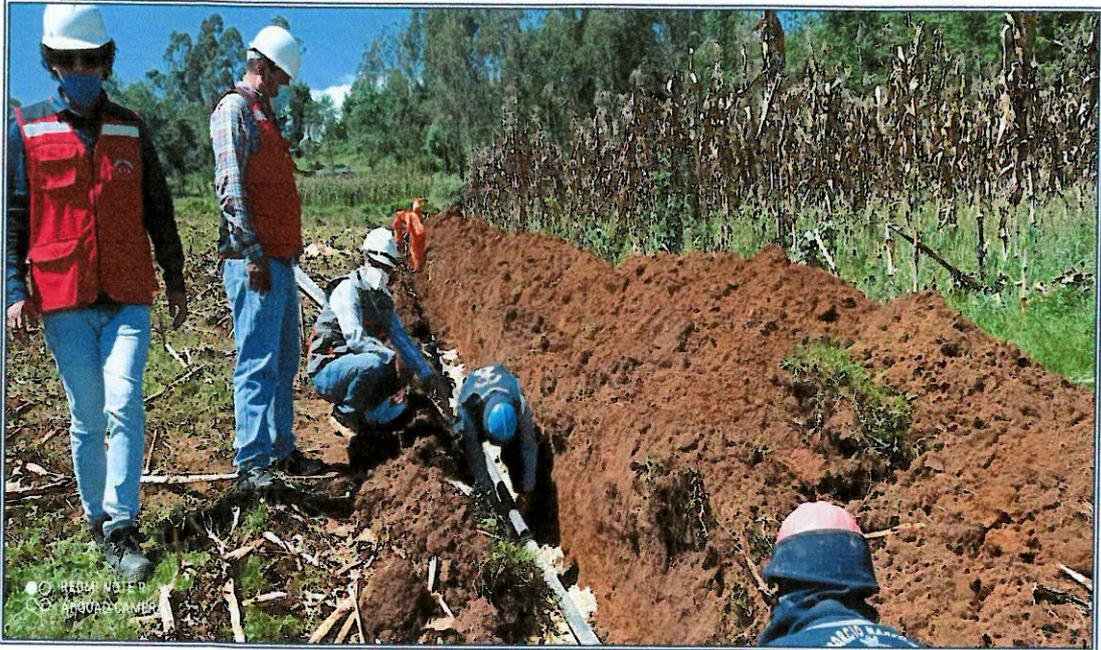
FOTOGRAFIA N°03: En la siguiente vista se observa a la Supervisión, Residente y Personal Técnico apreciando la ejecución de la partida 06.03.02.05 RELLENO Y COMPACTACION DE ZANJAS MANUAL, de la partida 06.03.02 MOVIMIENTO DE TIERRAS, de la partida 06.03 LINEA DE DISTRIBUCION de la partida 6 SISTEMA DE RIEGO 1 – MARCOPATA.
