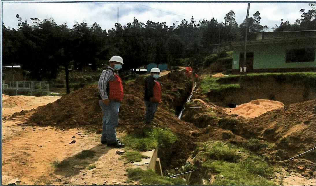
FOTOGRAFIA N°18: En la siguiente vista se observa a la Supervisión, Residente y Personal Técnico inspeccionando las actividades de la partida 08.02.02.04 CAMA DE APOYO PARA TUBERIA DE AGUA de la partida 08.02.02 MOVIMIENTO DE TIERRAS de la partida 8.02 LINEA DE DISTRIBUCION de la partida 8 SISTEMA DE RIEGO - NUEVO TRIUNFO.
