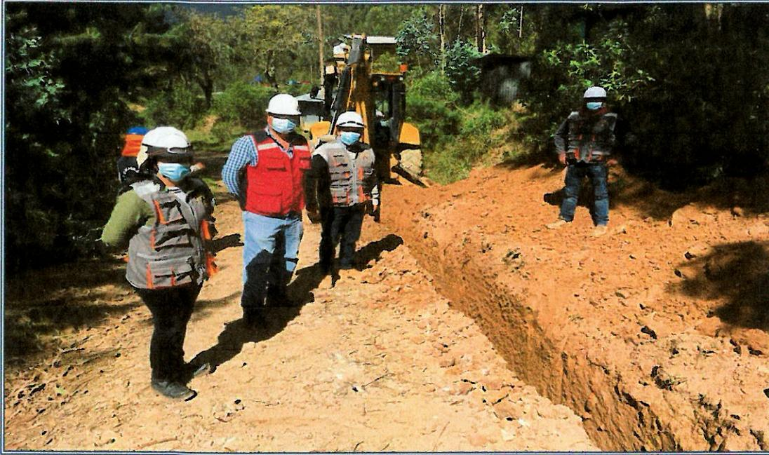
FOTOGRAFIA N°19: En la siguiente vista se observa a residente y supervisor de obra observando los trabajos realizados de la partida 08.02.02 EXCAVACION MASIVA CON MAQUINARIA EN ZANJA, de la Partida 08.02.02 MOVIMIENTO DE TIERRAS, de la partida 8.02 LINEA DE DISTRIBUCION de la partida 08 SISTEMA DE RIEGO - NUEVO TRIUNFO
