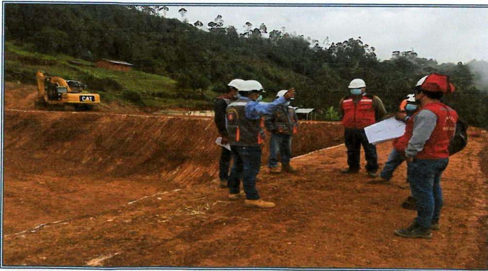
**FOTOGRAFIA N°02:** En la siguiente vista se observa a residente y supervisor de obra observando los trabajos realizados de la partida 06.02.02.01 EXCAVACION MASIVA CON MAQUINARIA PARA RESERVORIO, de la Partida 06.02.02 MOVIMIENTO DE TIERRAS, de la partida 06.02 RESERVORIO DE GEOMEMBRANA (1UND) de la partida 06 SISTEMA DE RIEGO 1 – MARCOPATA.
