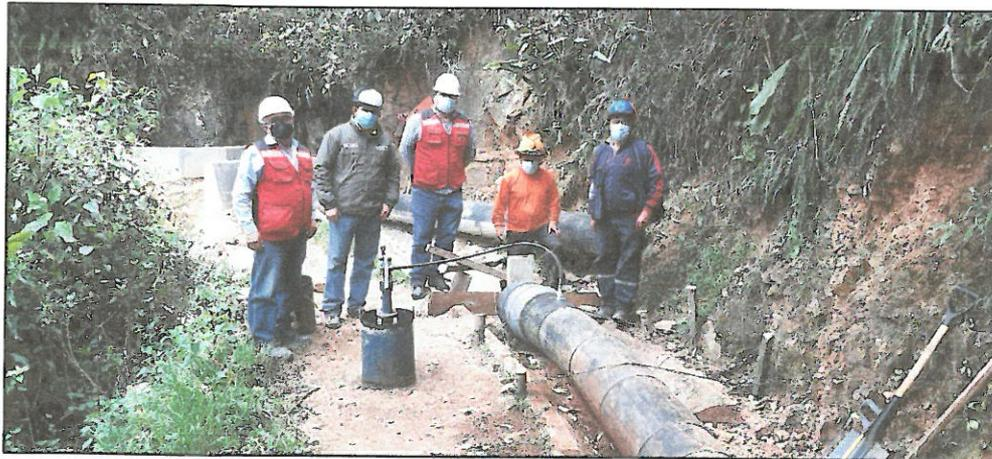
**PANEL FOTOGRAFICO N° 03:** Nótese los trabajos realizados en la Línea de Conducción con respecto a la rectificación de la unión de tubería HDPE a través del sistema de termofusión, Prueba Hidráulica realizada en la progresiva 1+000 hasta la 1+500.
