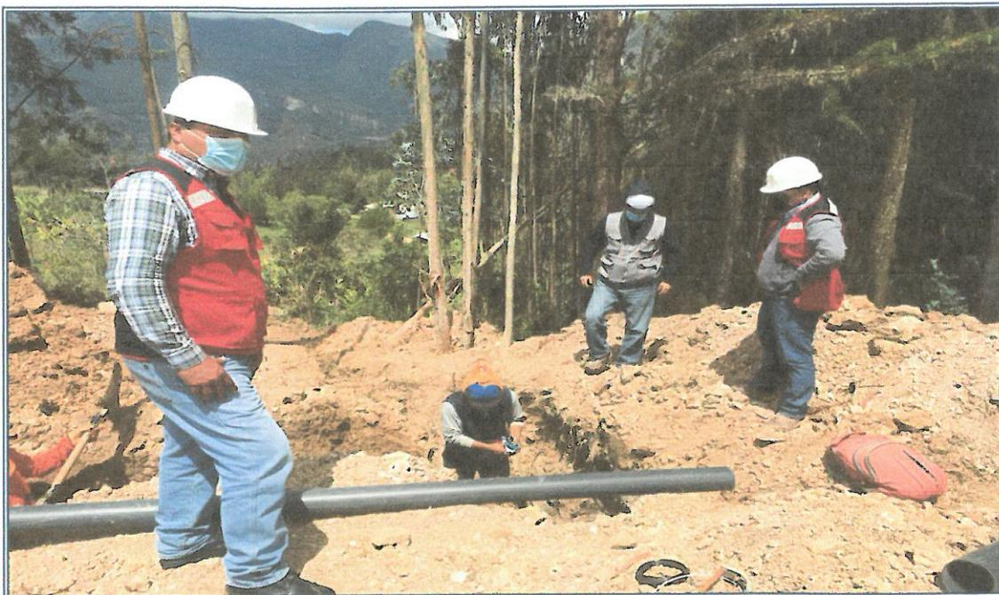
**FOTOGRAFIA N°01:** En la siguiente vista se observa a la Supervisión, Residente y personal técnico inspeccionando las actividades de la partida 08.02.03.05 SUMINISTRO E INST. DE TUBERIA PVC 110 mm C - 5, de la Partida 08.02.03 TUBERIAS., de la partida 08.02 LINEA DE DISTRIBUCION.
