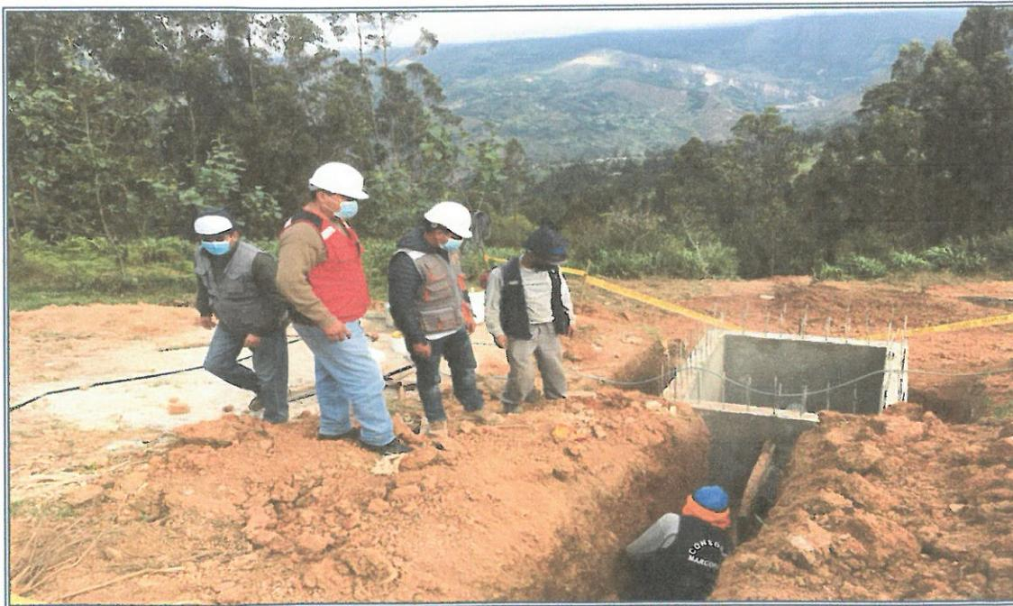
**FOTOGRAFIA N°03:** En la siguiente vista se observan los trabajos realizados, de la partida 08.02.03.02 SUMINISTRO E INST. DE TUBERIA PVC 250 mm C – 5, de la partida 08.02.03 TUBERIAS, de la partida 08 SISTEMA DE RIEGO - NUEVO TRIUNFO.
