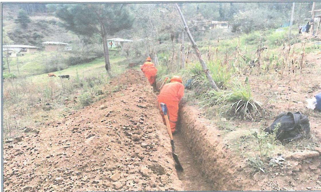
**FOTOGRAFIA N°05:** En la siguiente vista se observa a la Supervisión y residente de obra, están apreciando la ejecución de la partida de la partida 08.02 LINEA DE DISTRIBUCION,, de la partida 06.05.02 MOVIMIENTO DE TIERRAS, de la partida 08.02.02.01 EXCAVACION MANUAL DE ZANJAS, de la partida 08 SISTEMA DE RIEGO - NUEVO TRIUNFO.
