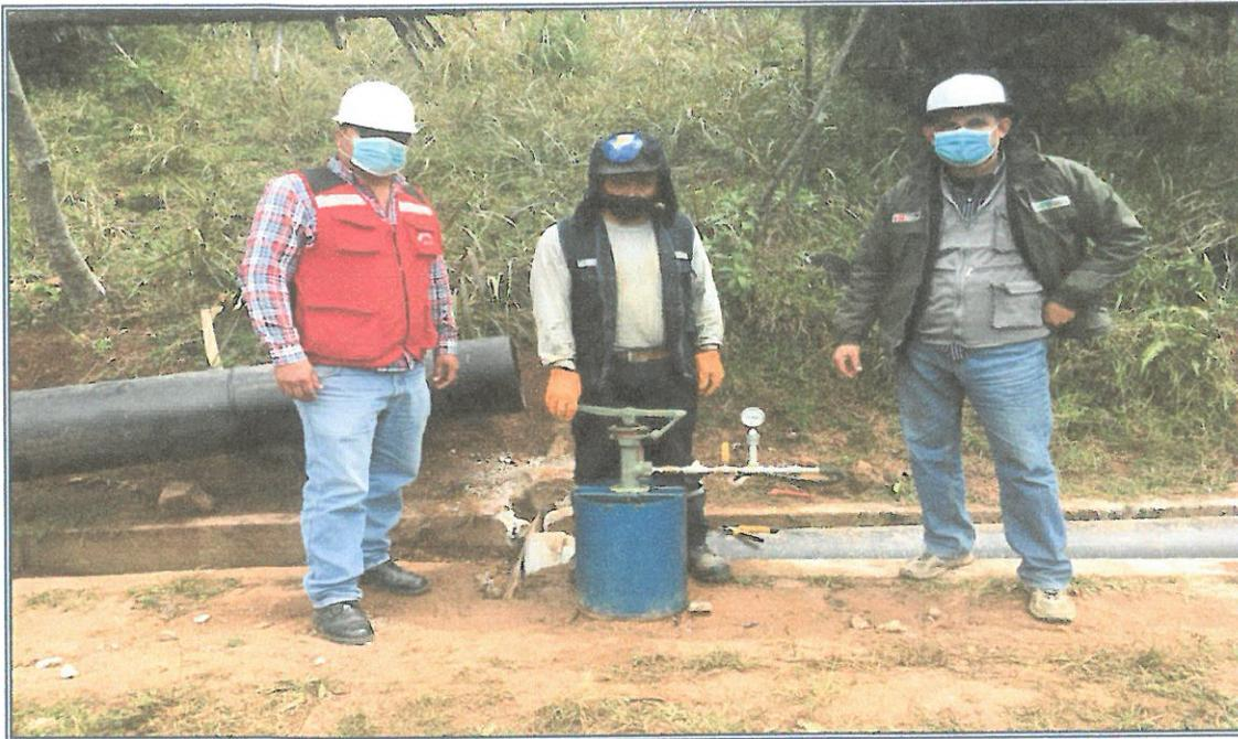
**FOTOGRAFIA N°04:** En la siguiente vista se observan los trabajos realizados, de la partida 03.02.15 PRUEBA HIDRAULICA, de la partida 03 TUBERIA DE CONDUCCION.
